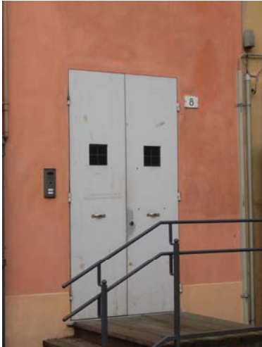
Saletta del Suffragio ingresso da via Fornasini
