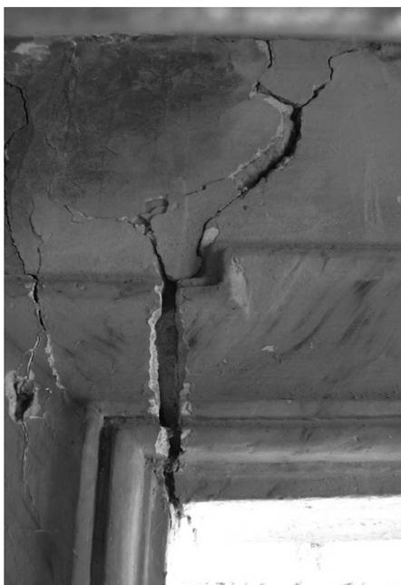
smaltimento delle acque meteoriche, a questo ha fatto seguito il consolidamento delle fondazioni e delle strutture murarie lesionate, il recupero delle volte e l'integrazione degli intonaci esistenti con altri a base di calce naturale dotati di un ottimo potere deumidificante e con caratteristiche molto simili a quelle dei materiali storici.
