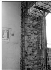
*Il traliccio in acciaio di trattenimento della facciata: sopra di esso i canali dell'aria. A lato: parete di muratura a sacco tra il volume "sagrestia" e il vano scale di sicurezza. A destra: il modello tridimensionale includente anche Casa Ghelli*
