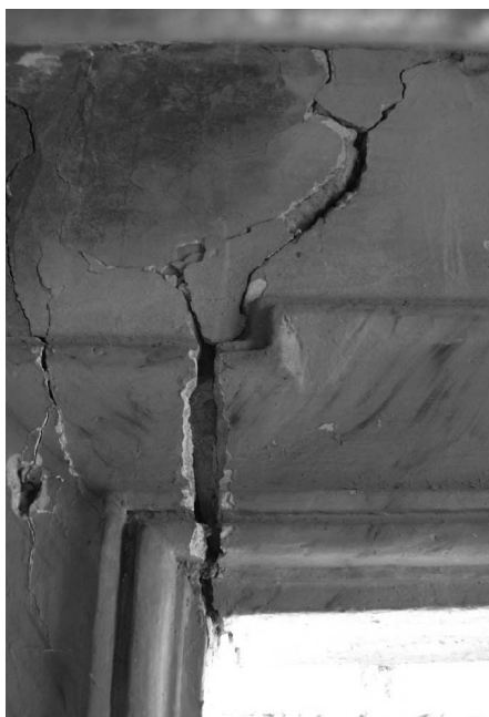
Dettaglio del cedimento di uno degli architravi. Nella foto in alto: l'altare
