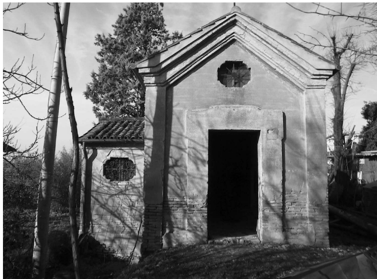
L'oratorio prima dell' intervento visto dalla via Muzzaniga
