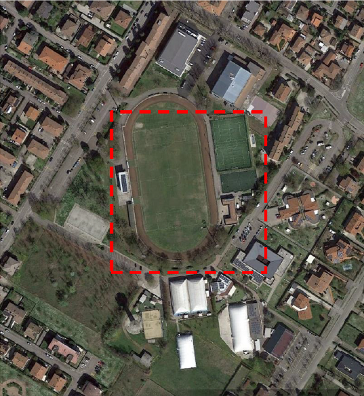
Foto Aerea – Area lungo il perimetro dello stadio
